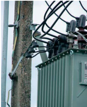
początek linii napowietrznej nn
