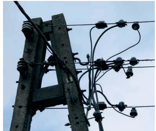
koniec linii napowietrznej nn
