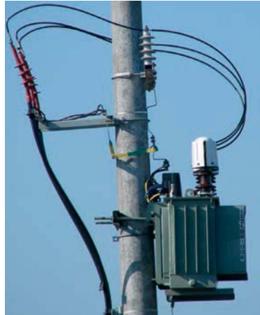
zabezpieczenie uproszczonej stacji transformatorowej 15/0,4 kV
