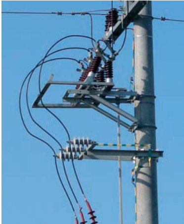
zabezpieczenie kabla SN – zejście z linii napowietrznej
