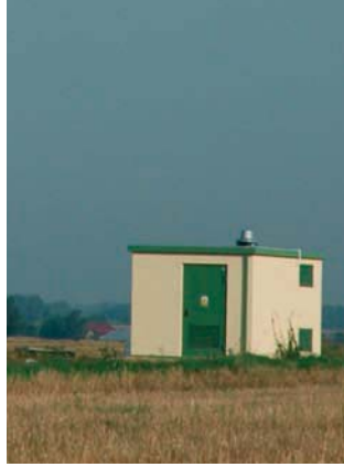
stacja transformatorowa 15/0,4 kV
